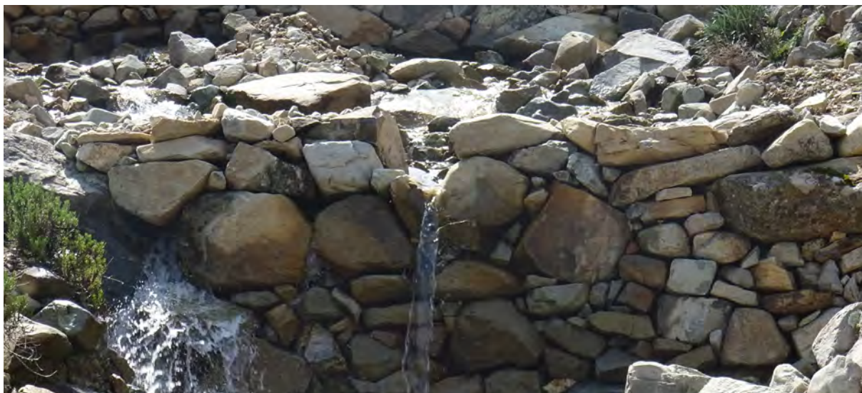
Figura N° 8: Diques transversales contruidos por la comunidad de San Pedro de Casta, ubicado por encima de la captación del canal amunero Saywapata Fotografía: Rene Pumayalli-Unu Kamachiq
