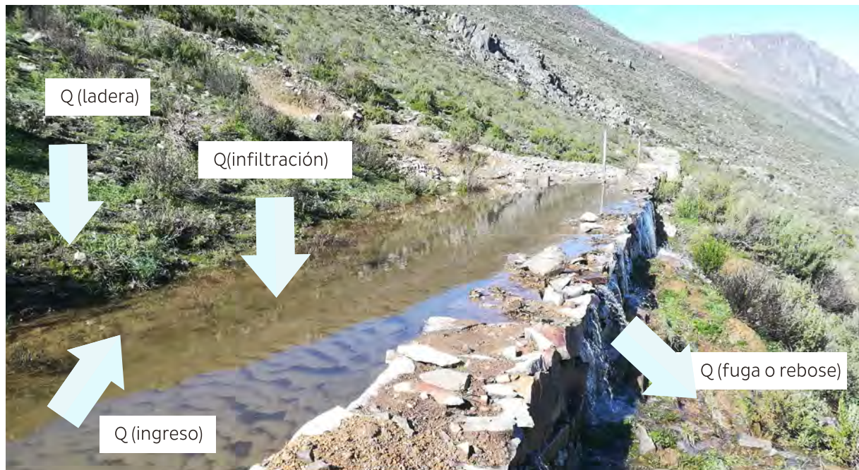
Figura N° 11: Esquema Caudales de Ingreso, Infiltración, Fuga y Aporte de Ladera Fuente: CITA-UTEC
