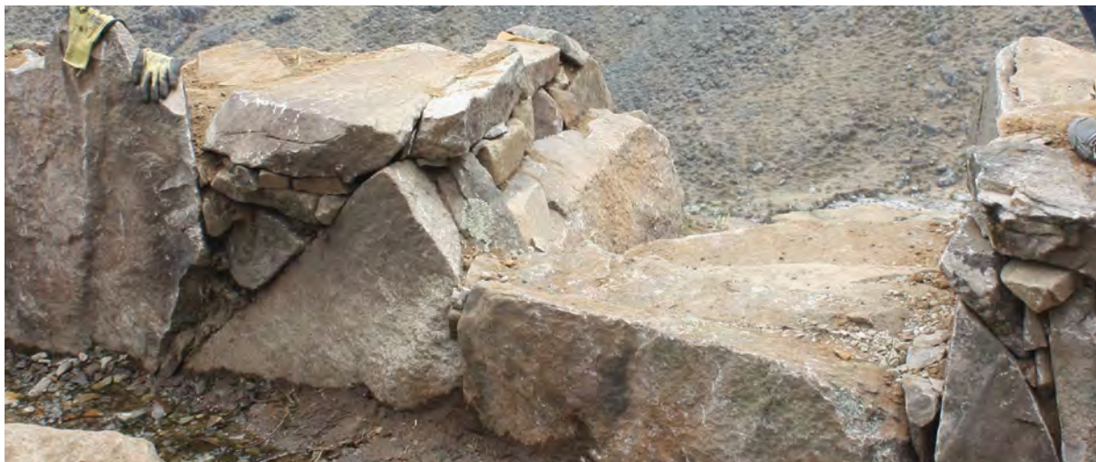
Figura N° 7: Vertedero de excedencias, realizado en el canal amunero Saywapata Fotografía: Alfredo Salinas-TNC
