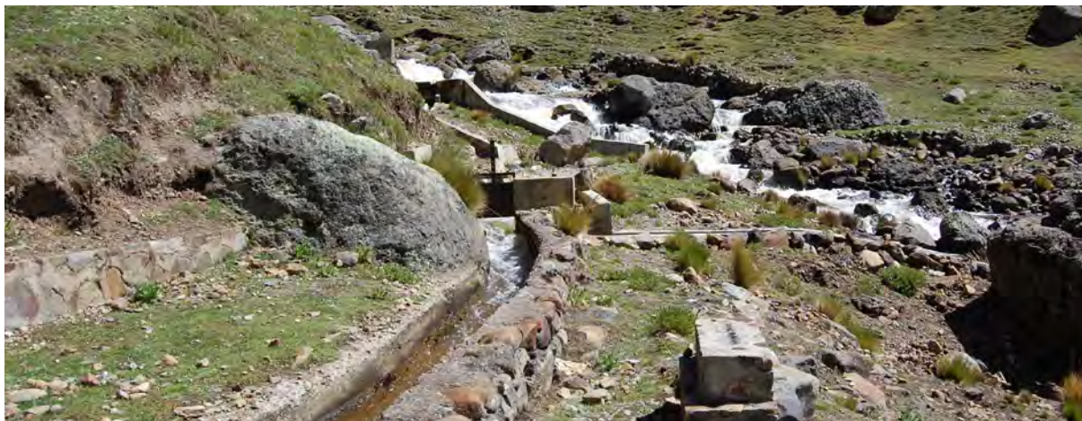
Figura N° 23: Canal Acobamba recubierto con concreto en su parte inicial
