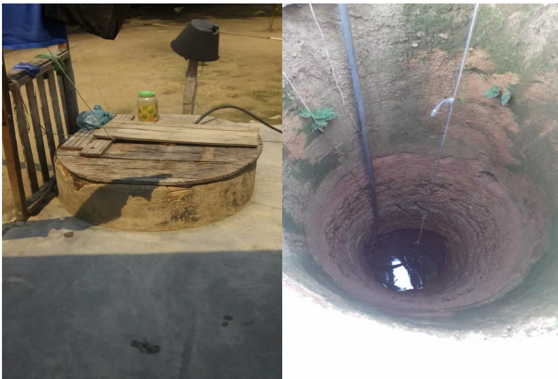
Figura 6 - Poços amazônicos e sistema de bombeamento. Fonte: Acervo associação comunitária de Pimental.
